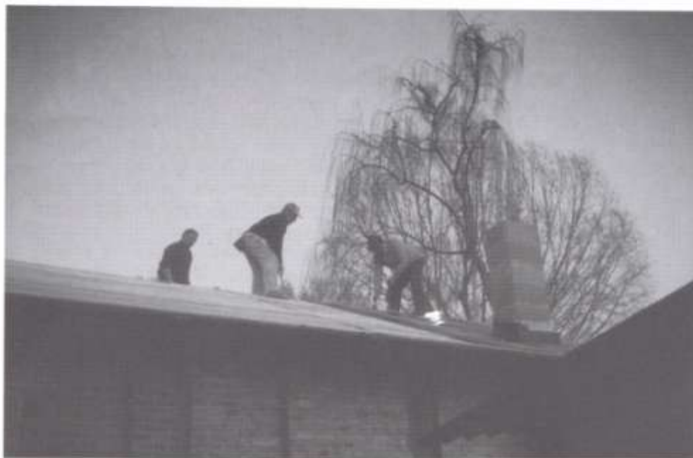
Durante i lavori.
