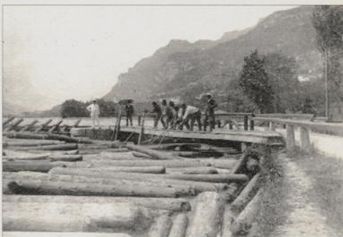
1930: Operai delle segherie Malcom di Longarone incanalano le "taglie" (tronchi) provenienti dall'alto Piave
