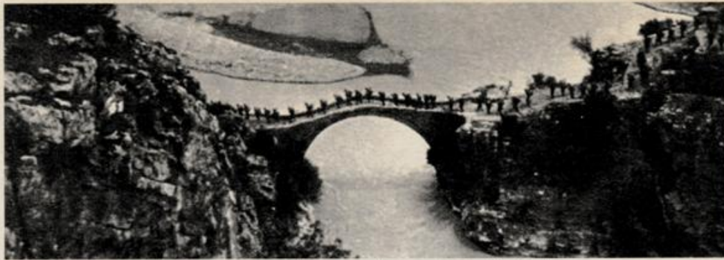
Grecia 1940: un reparto della Julia transita su uno dei pochi ponti ancora esistenti sui fiumi in piena.
