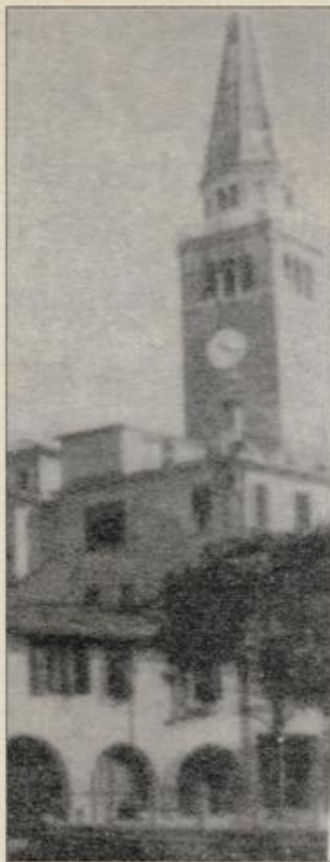
Portogruaro: scorcio col campanile
