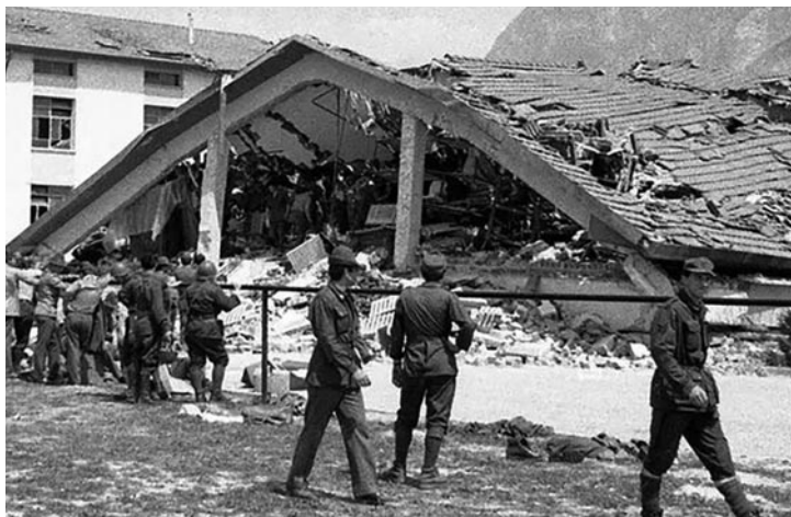
Ciò che resta di una palazzina della Caserma Goi-Pantanali
